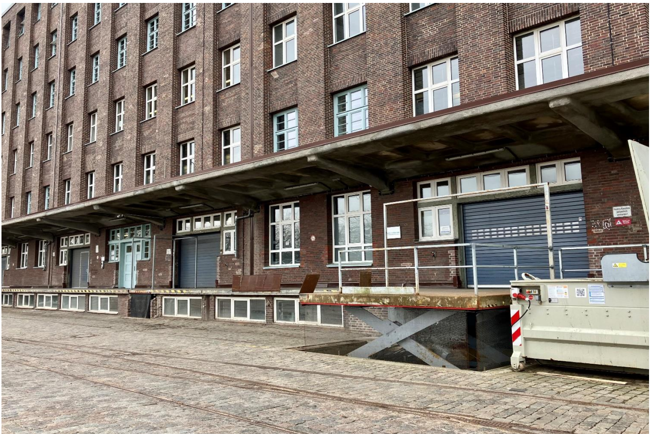
Vorderer Anlieferungsbereich mit Rampe
