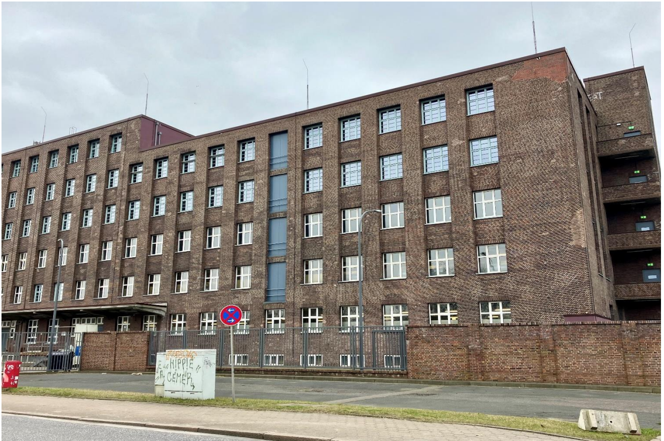
Außenansicht des Gebäudes von der Peutestraße
