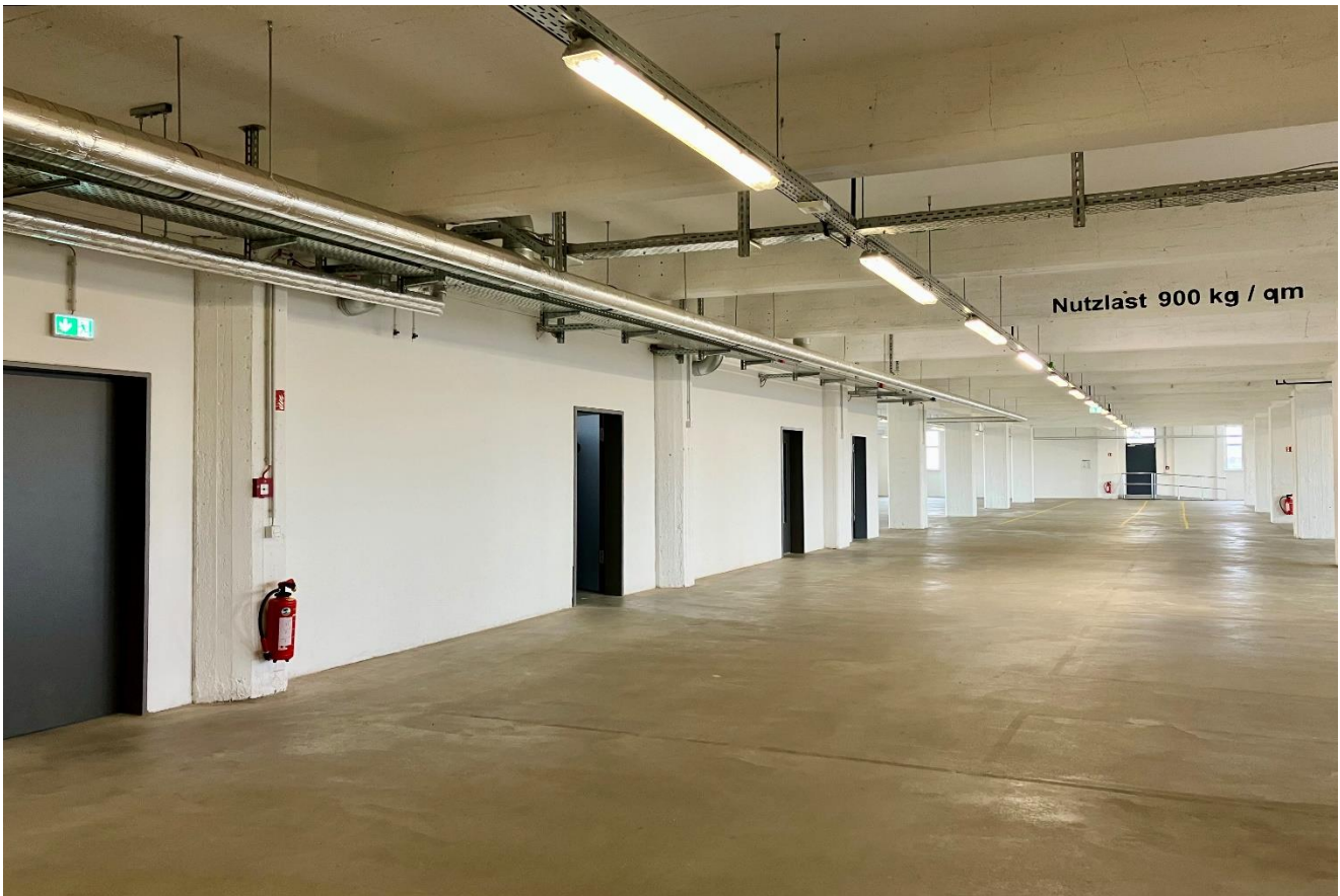
Ansicht Lagerfläche mit Sozialräumen links
