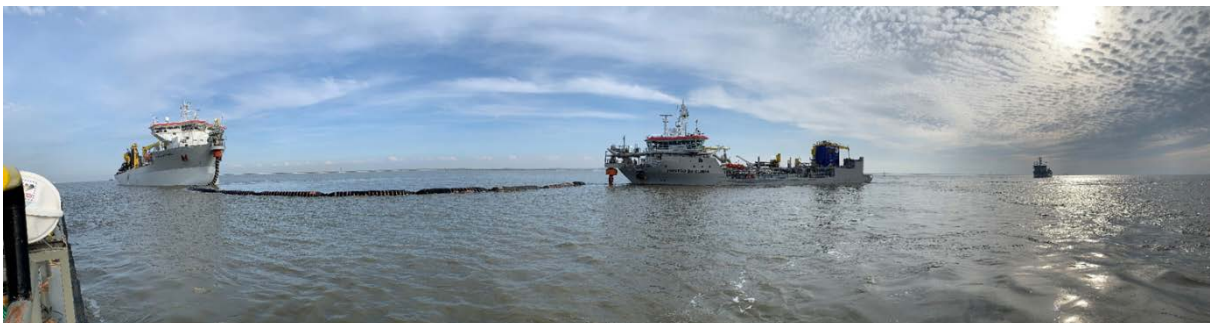
Abb. 1: Übergabe von Ausbaubaggergut zum Einbau in die Unterwasserablagerungsfläche Neufelder Sand (Foto: Sebastian Sandt).
