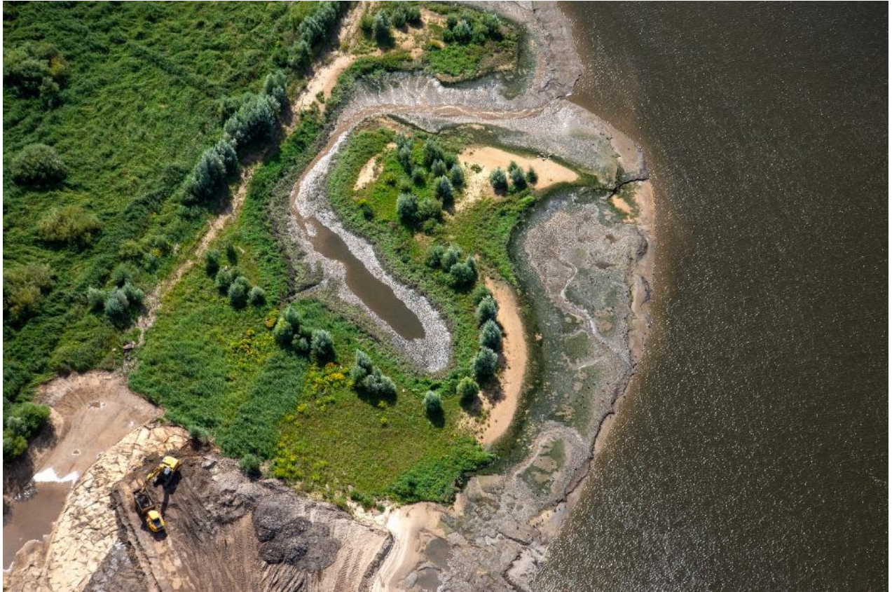
Abbildung 4: Detail (Priel) des im Bau befindlichen Flachwassergebiets Kreettsand (Foto: Holger Weitzel, 2021).
