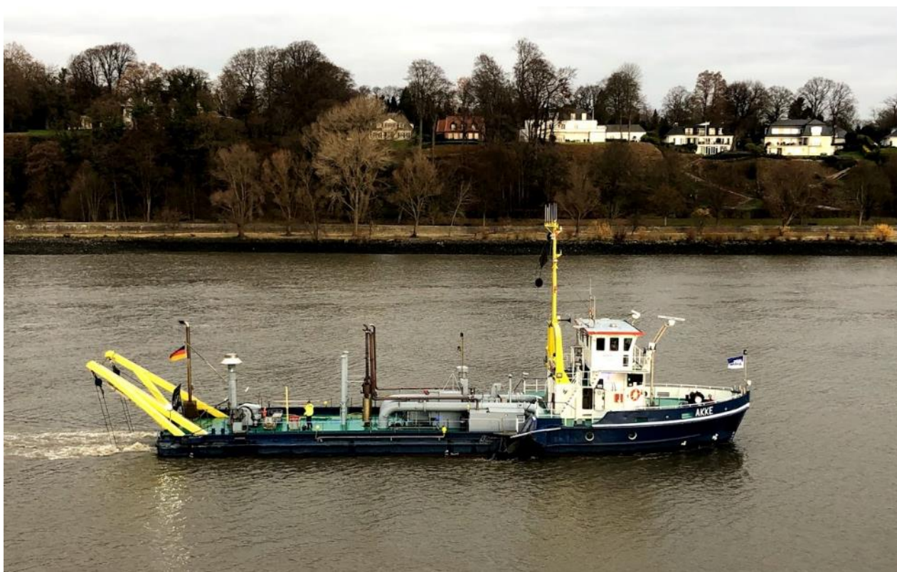
Abbildung 9: Wasserinjektionsgerät Akke im Einsatz auf der Riffelstrecke (Foto: Christian Jonas).
