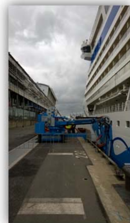
Abbildung 5 Links: Darstellung der Landstromanlage. Rechts: Übergabeeinrichtung zum Schiff (Fotograf: Lars Stücken/HPA).
