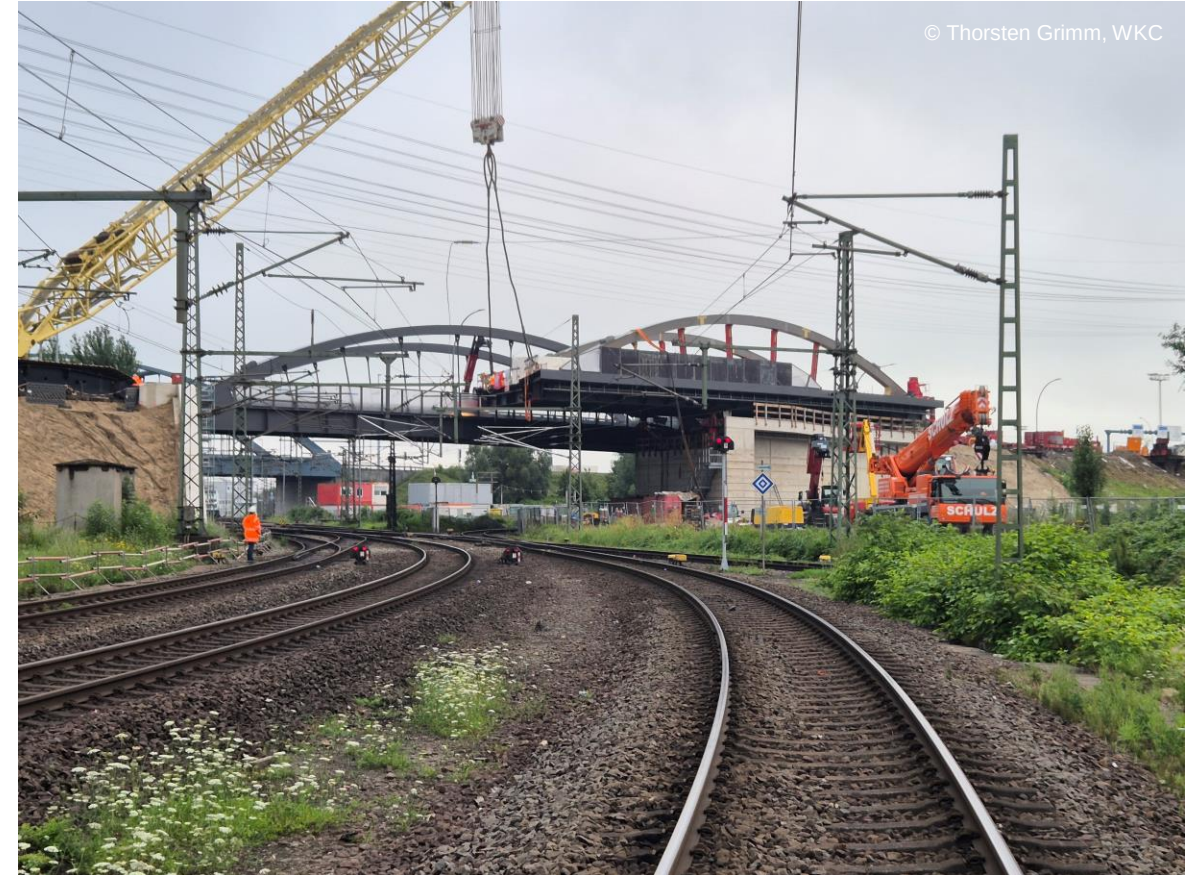
Einschub am 02.08.2025 – Anschlagen des 800 t - Raupekrans
