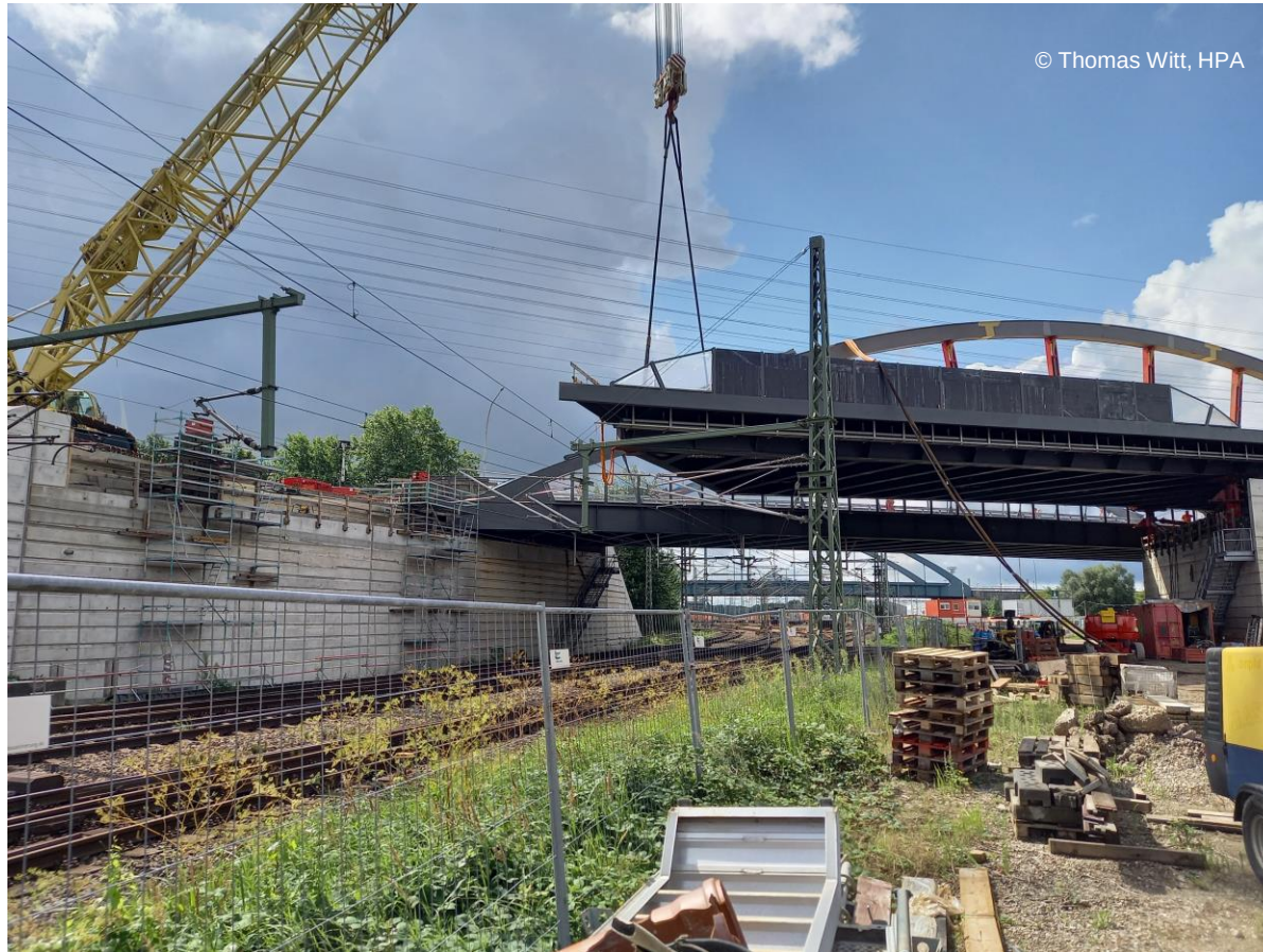
Einschub am 02.08.2025 – Arbeiten oberhalb der Hafenbahngleise
