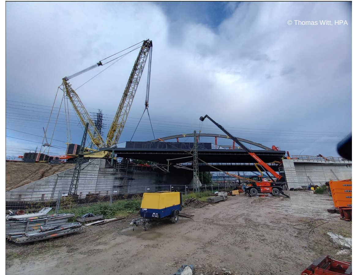
Absetzen der Brücke in “Endlage” am Abend des 02.08.2025
