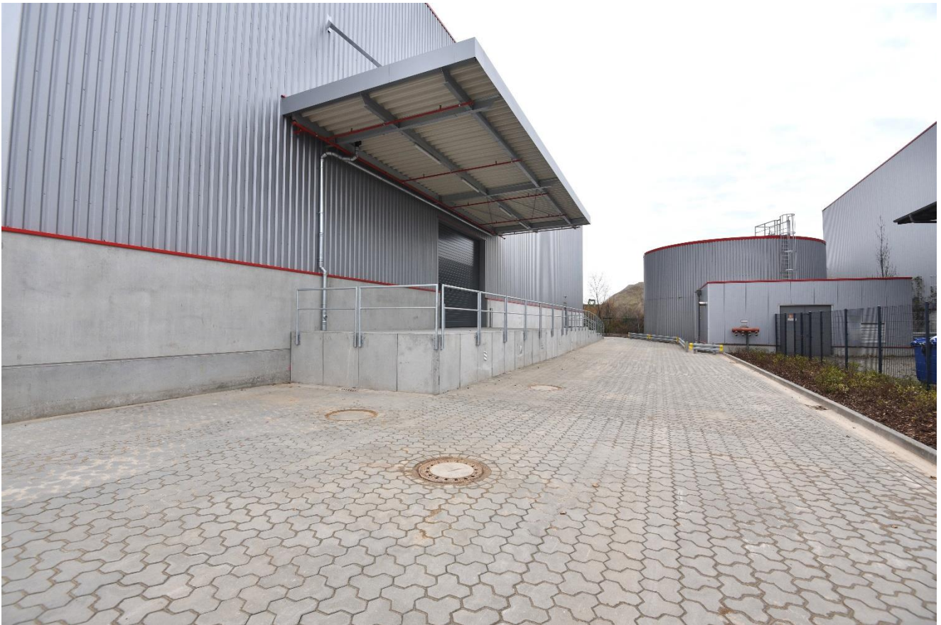
Ansicht der Rampe
