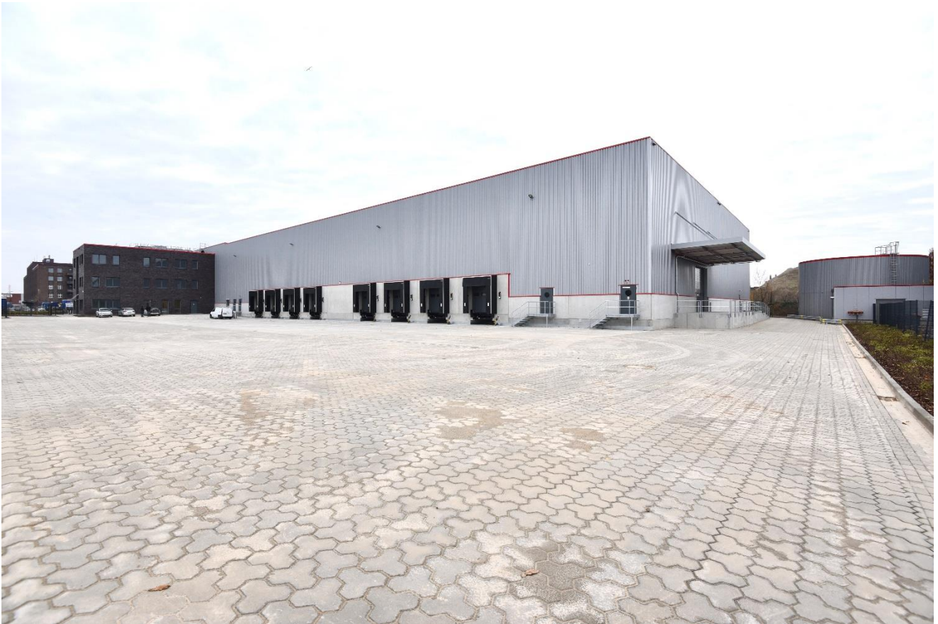
Seitenansicht der Logistikhalle sowie des Bürogebäudes
