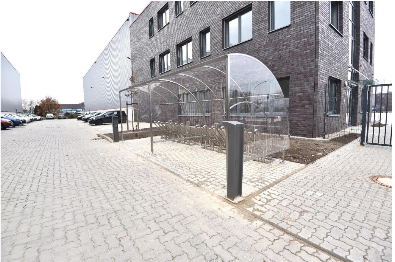
Seitenansicht des Bürogebäudes
